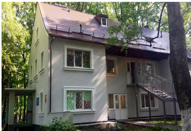
Поликлиническое отделение №1 Отремонтированный фасад здания. 2019г.
